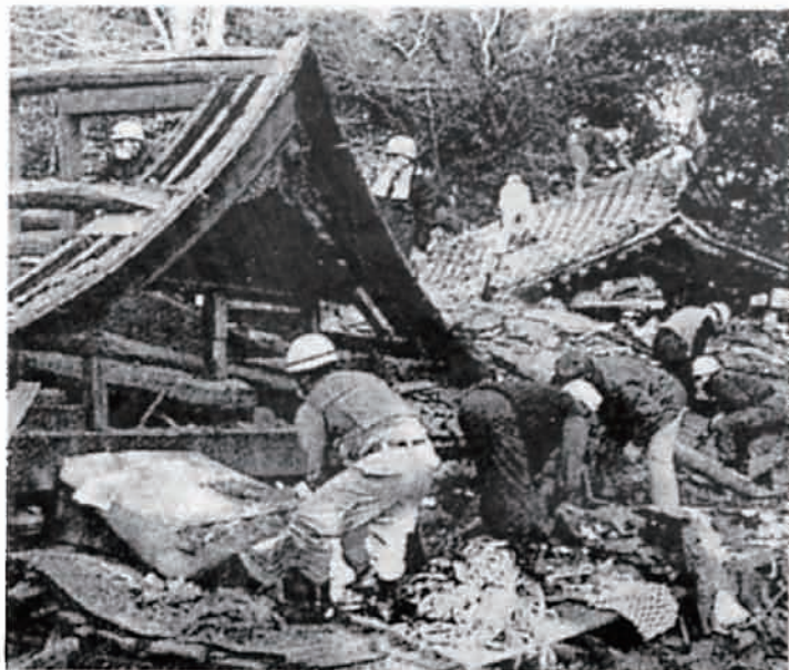
倒壊した神社の撤去作業をする神職 (尼崎市武庫元町で、午前 8 時)
